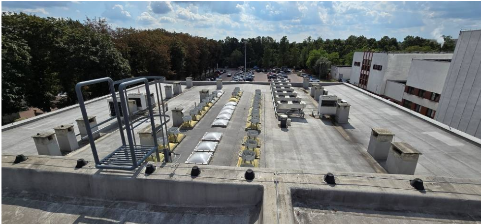
Fot. 6 Widok z dachu segmentu II na dach segmentu I.
