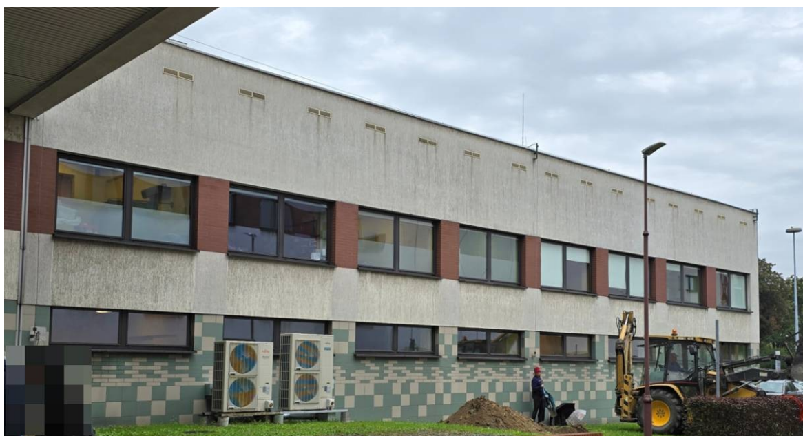
Fot. 2 Elewacja boczna, południowo – zachodnia
