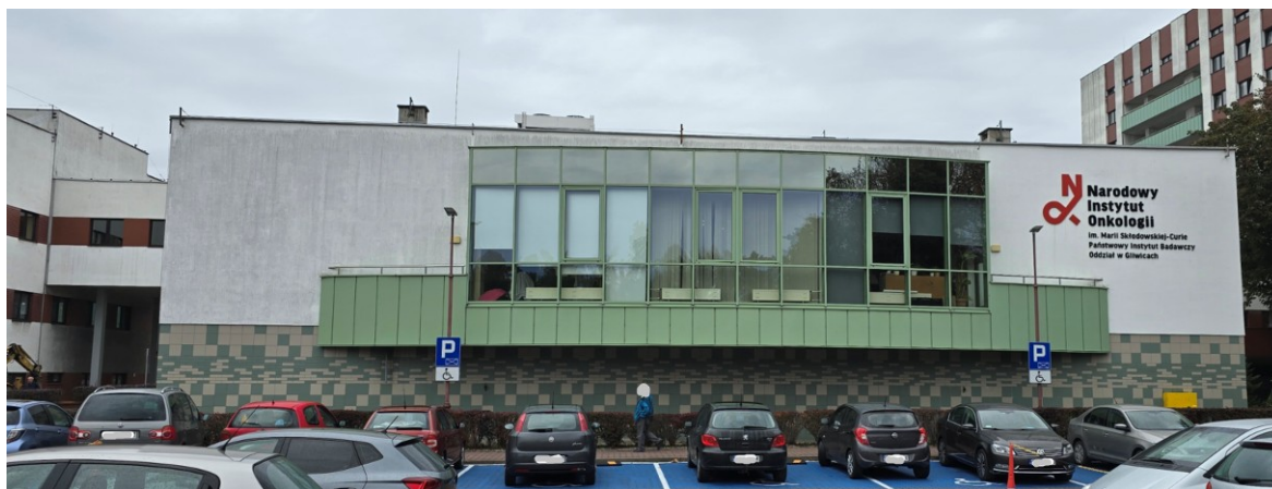
Fot. 1 Elewacja frontowa, południowo-wschodnia.
