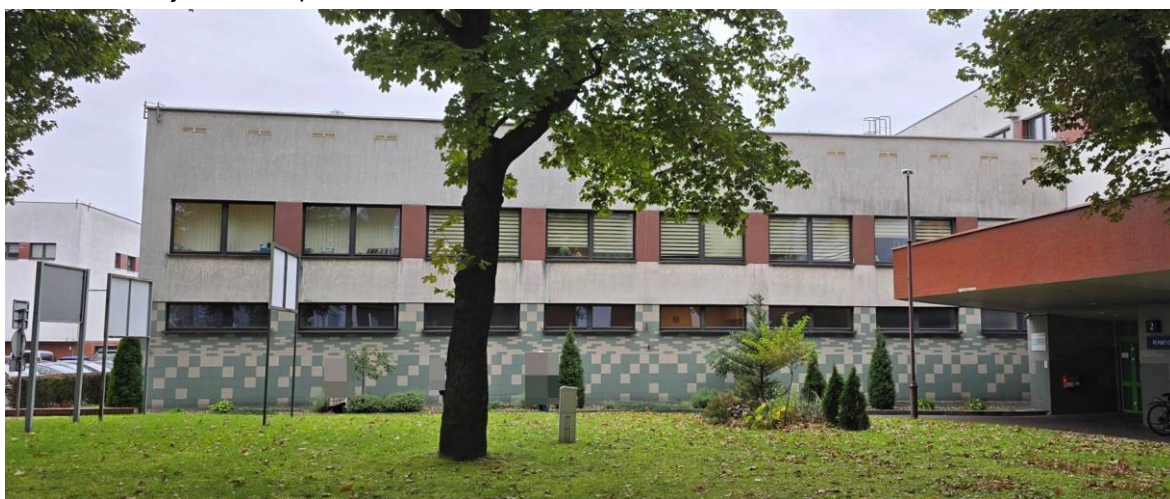
Fot. 4 Elewacja boczna, północno – wschodnia.
